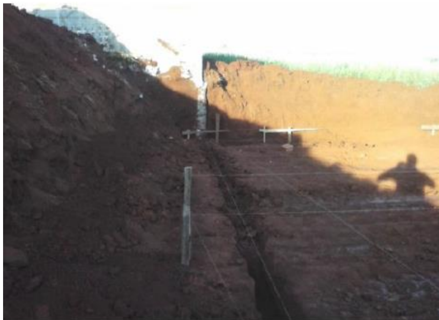
Imagem 1– Gabaritos, etapa anterior a furação de estacas.
