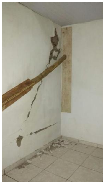
Imagem 38 – Escora de apoio a estrutura
