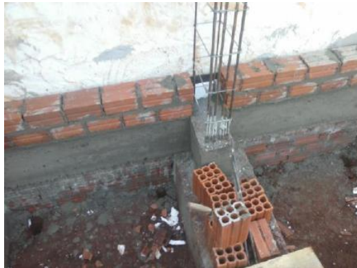
Imagem 09 – Muro de arrimo junto a estrutura vizinha
