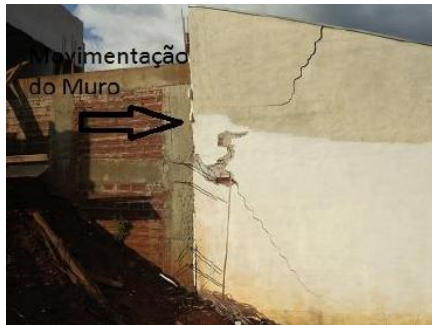
Imagem 21 – Junta de dilatação, com falha na execução
