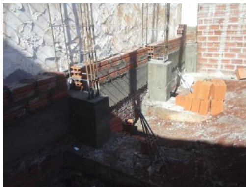
imagem 08 – Muro de arrimo junto a estrutura vizinha
